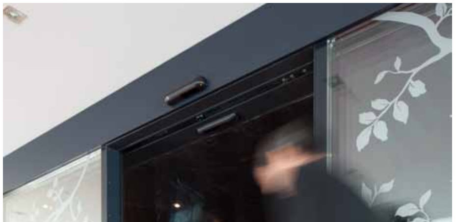
Fire proof sliding door (EI30), Zurich, Suisse
